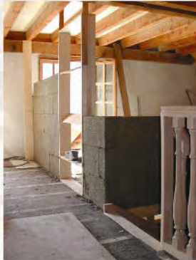
construction de cloisons en blocs de chanvre de 10 cm
