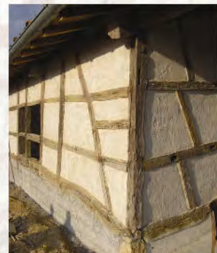
remplacement d'un torchis par des blocs de chanvre et enduit sable et chaux
