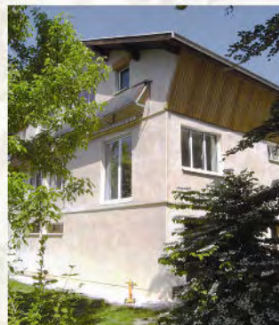
isolation extérieure en blocs de chanvre et enduits sable et chaux
