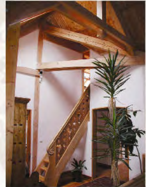
cloisons en blocs de chanvre enduites au mortier de sable et de chaux
