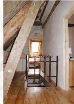
aménagement de combles : isolation des murs et cloisons en blocs de chanvre
