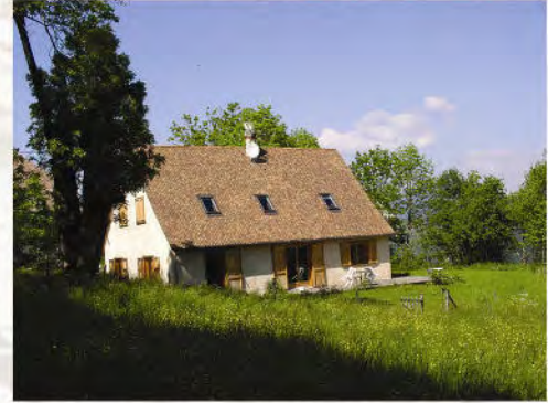
maison d'habitation à ossature bois poteau poutre et blocs de chanvre
