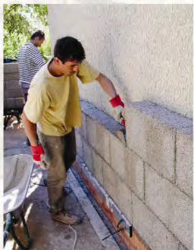
pose de blocs de chanvre en isolation extérieure d'un mur en blocs béton
