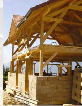
construction d'une maison à ossature bois poteau poutre et blocs de chanvre
