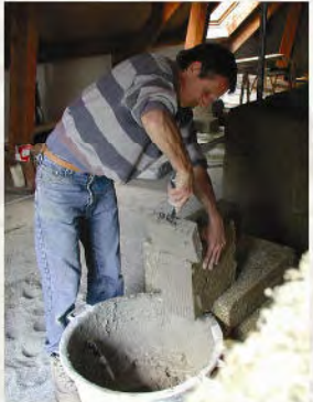
encollage d'un bloc de chanvre au mortier de chaux
