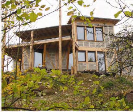
construction d'une maison à ossature bois et blocs de chanvre
