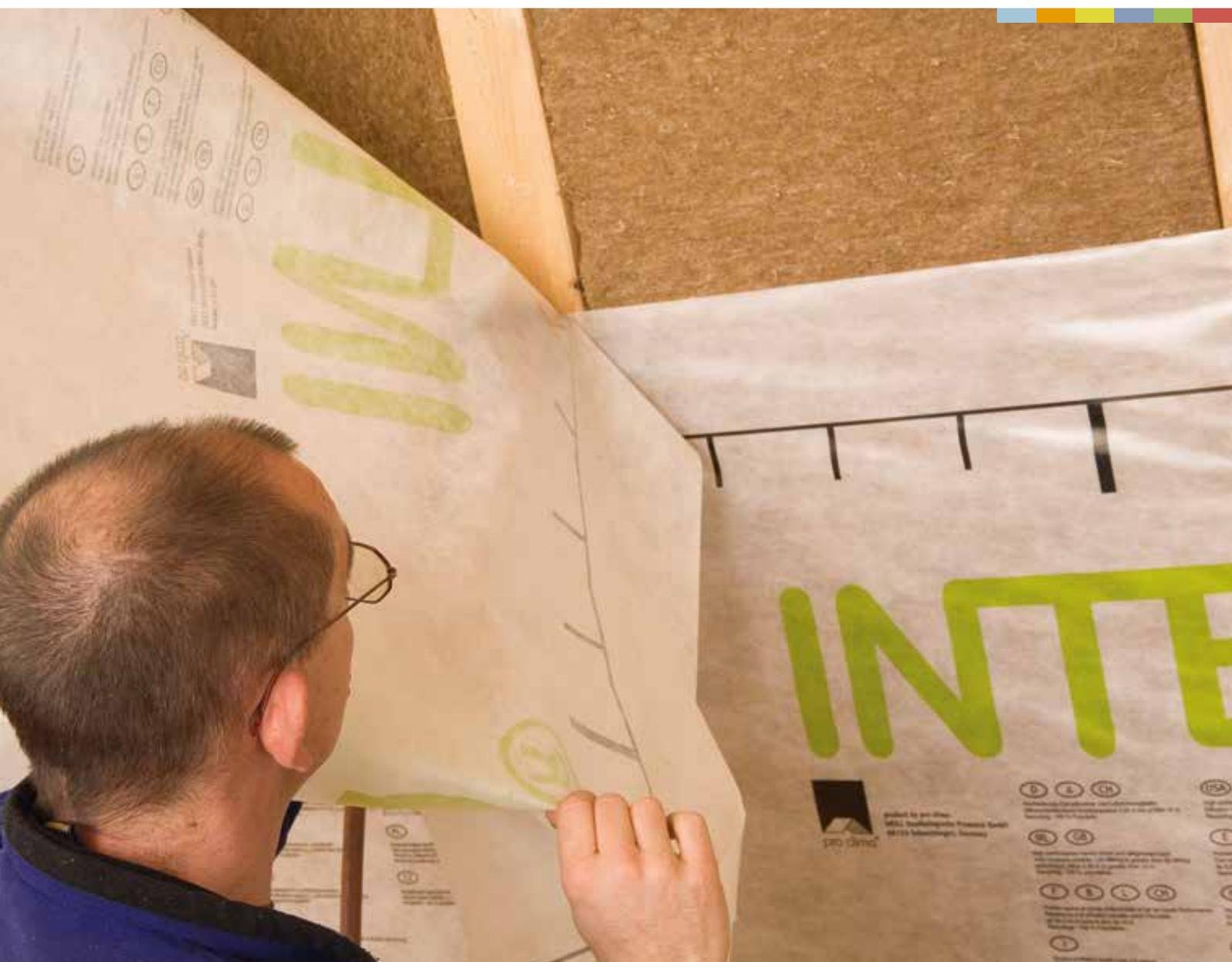
Système haute performance avec la membrane d'étanchéité à l'air et frein-vapeur pro clima INTELLO
