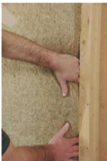
Panneau d'isolant à base de fibres végétales biosourcées, destiné à réaliser l'isolation :
